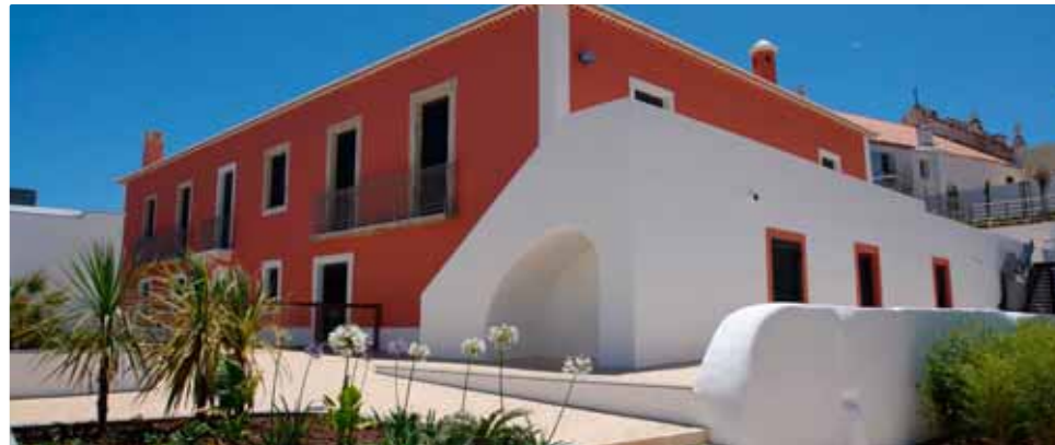
Reabilitação da Casa da Fogaça e conversão em Centro de Ciência Viva, Lagos, Algarve Restructuring work of Casa Fogaça, Installation of the Live Science Center, Lagos, Algarve
