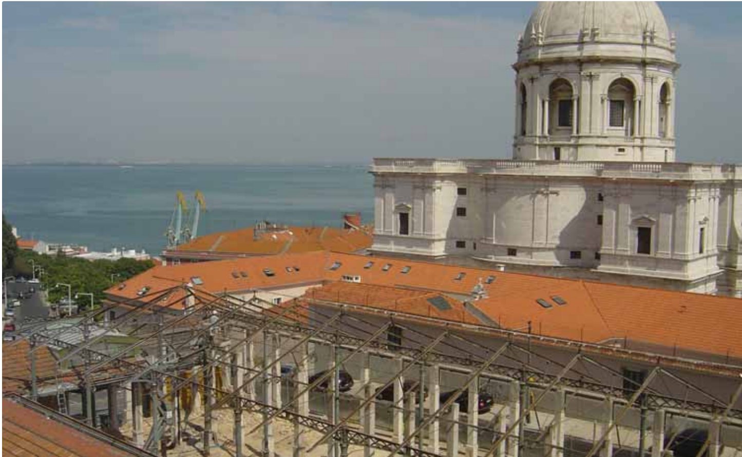
Reabilitação do Mercado de Stª Clara, Lisboa, Portugal Restoration of Santa Clara Market, Lisbon, Portugal
