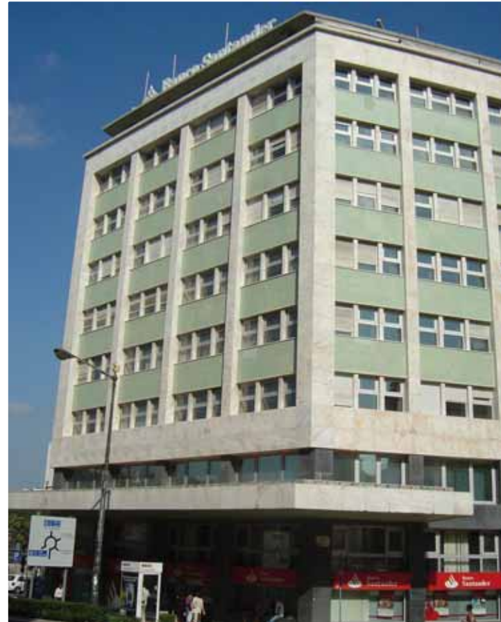
Reforma Interior para Escritórios em Edifício no Marquês de Pombal, Lisboa, Portugal Interior Refurbishment into Offices of a Building in Marquês de Pombal, Lisbon, Portugal
